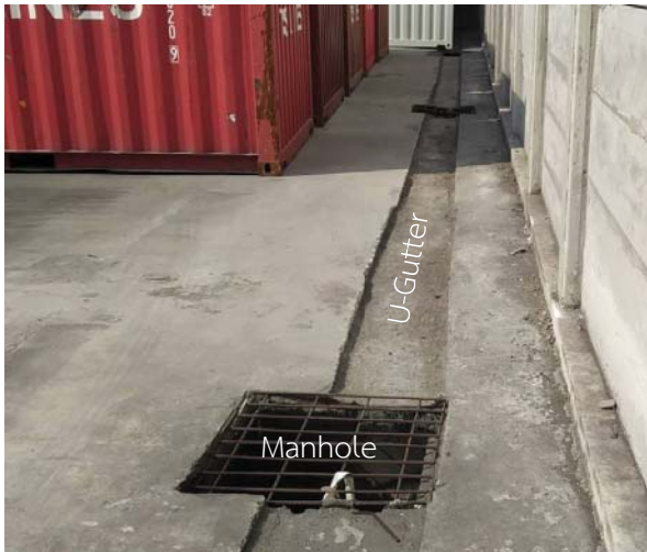
ระบายน้ำขนาดเล็ก (U-Gutter) และบ่อพักน้ำ พร้อมฝาตะแกรงเหล็กด้ามฝั่งริมรั้วทิศเหนือ
