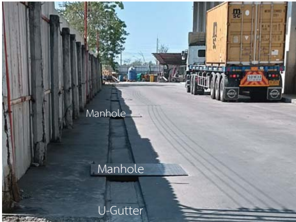
แนวร่องระบายน้ำ (U-Gutter) และบ่อพักน้ำ พร้อมฝาตะแกรงเหล็กด้ามฝั่งริมรั้วทิศใต้
